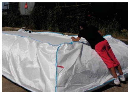
Doťahovanie popruhov záchytnej vane
